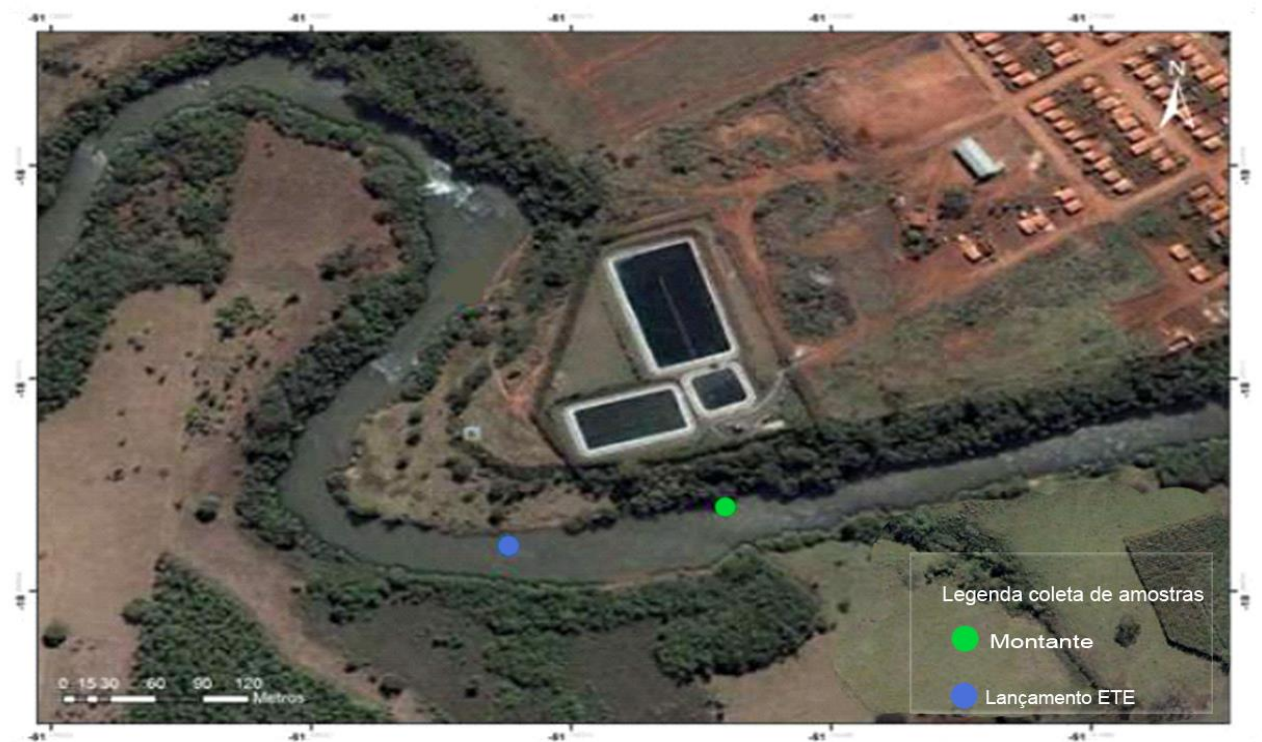
Figura 1 - Locais de coleta das amostras de água superficial no ponto a montante e lançamento da ETE de Aparecida do Rio Doce. Fonte: Adaptado do Google earth (2016).
